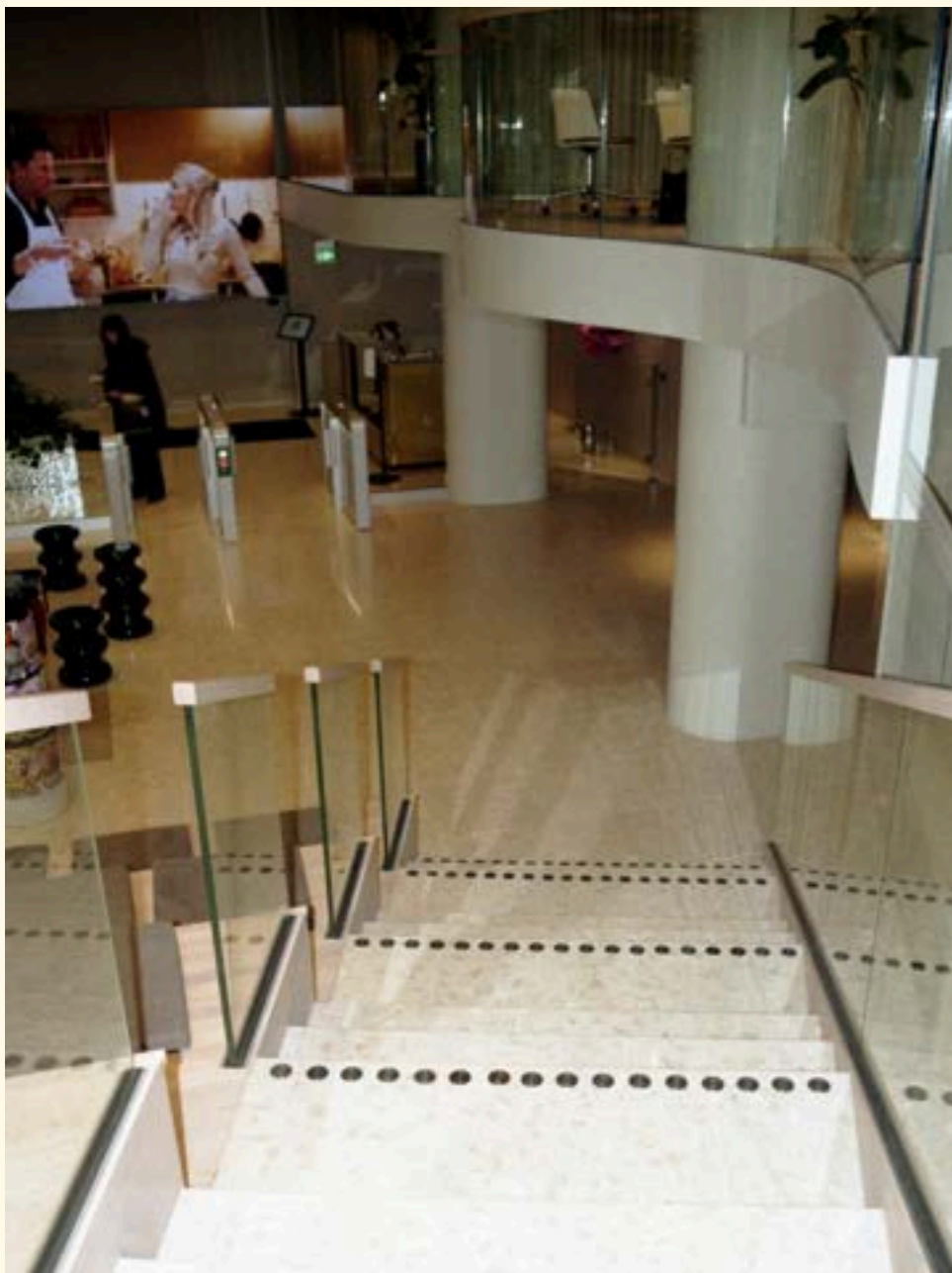
Safestep SVARTBÄCKEN - kontrastmarkering i rostfritt stål med svart PVD-beläggning. Aller media, Stockholm.
