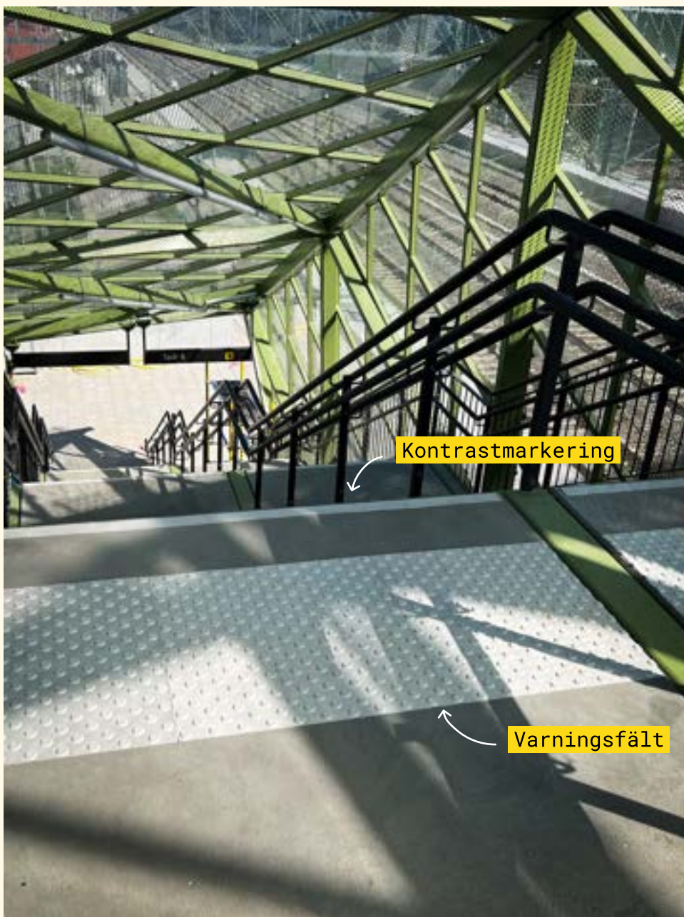
Safestep SALA BACKE - stoppmarkering i polyuretan och Safestep HÅGA - kontrastmarkering i termoplast. Hjärup station.
