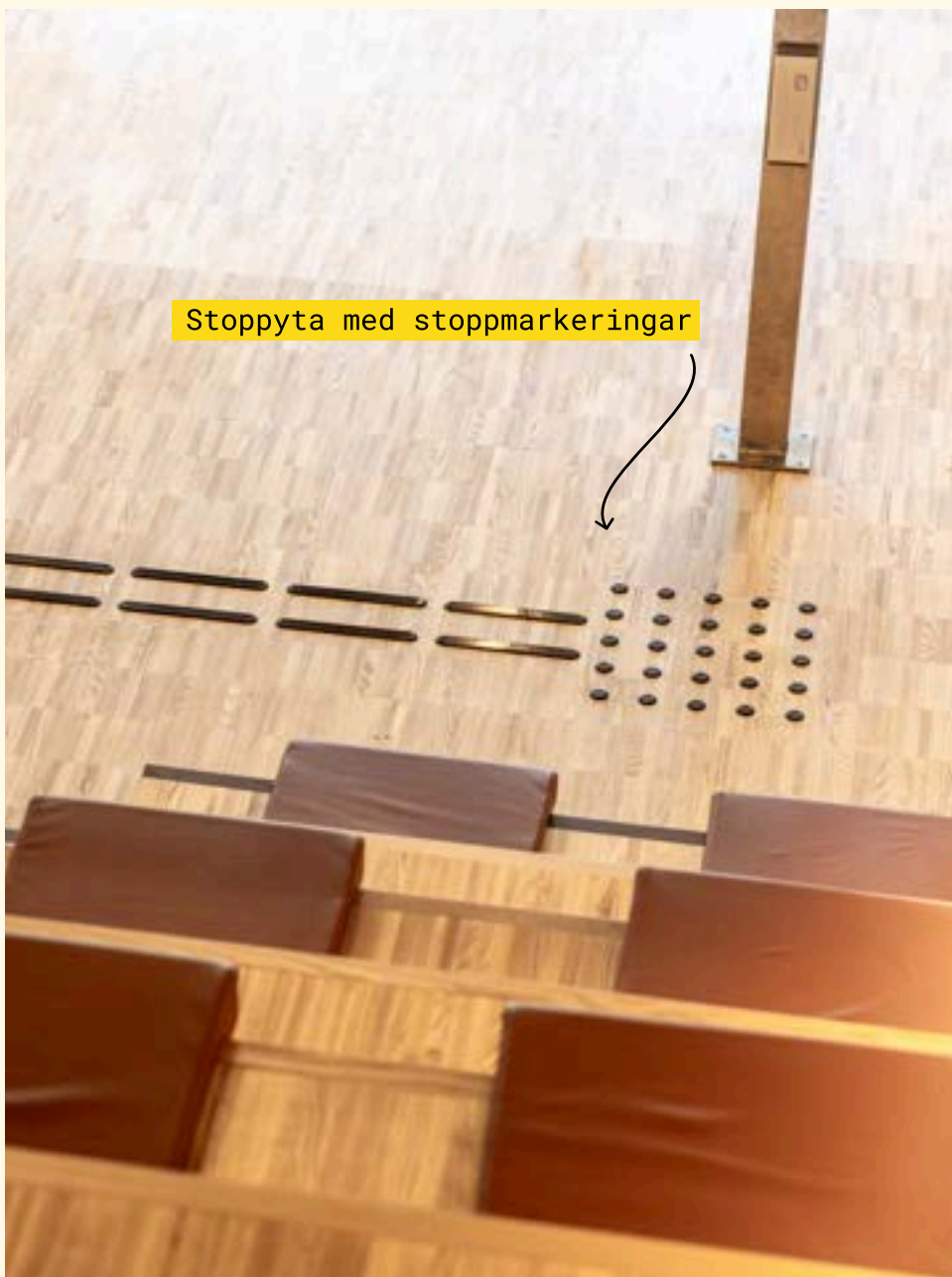
Safestep SVARTBÄCKEN - taktila ledstavar och stoppmarkeringar i svart rostfritt stål. Enköpings kommunhus, Enköping.
