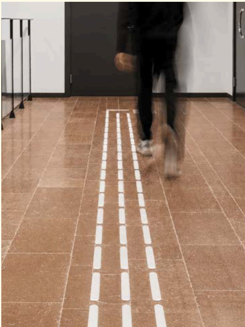
Safestep VITBÄCKEN - taktila ledstavar i vitt rostfritt stål med linjerad yta. Kristenhamns kommunhus, Kristinehamn.
